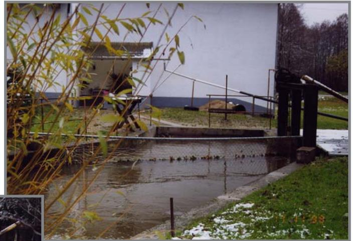
Am Wehr wird der Zu- und Abfluss zur Turbine reguliert. Das Mühlrad existiert schon lange nicht mehr.
